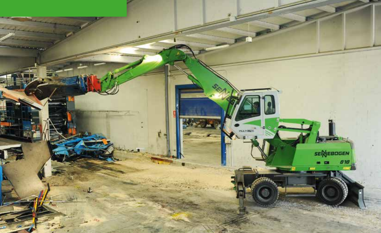
818 M - with scrap shears - demolition inside a hall; Spain 818 M - mit Schrottschere - Abbruch in einer Halle; Spanien
