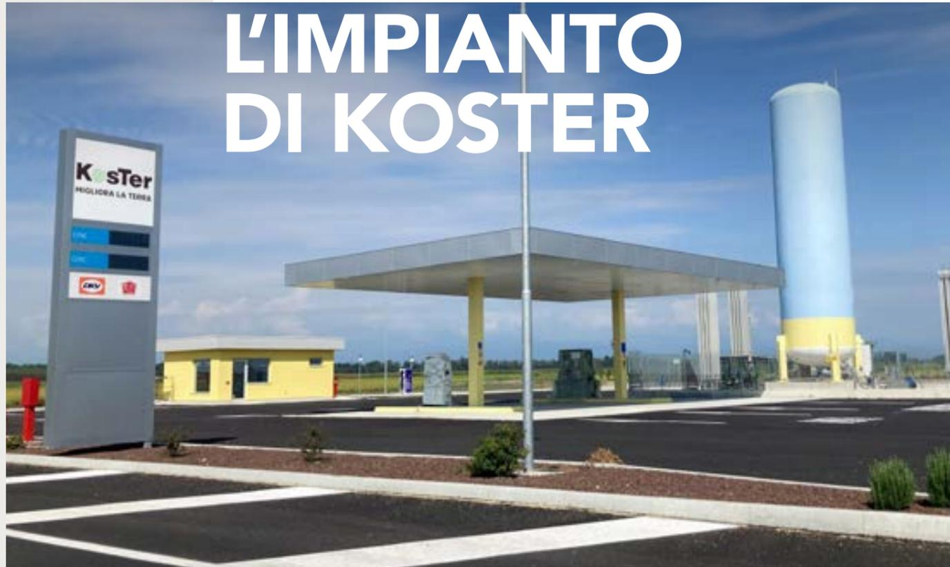
PROGETTATO E SVILUPPATO IN COLLABORAZIONE CON CESARO MAC IMPORT, L'IMPIANTO È STATO CONCEPITO PER TRASFORMARE CIRCA 60.000 TONNELLATE DI RIFIUTI ALL'ANNO, IN BIOMETANO, GRAZIE A UN SISTEMA DI DIGESTIONE ANAEROBICA CHE AVVIENE ALL'INTERNO DI DUE DIGESTORI DA 2.100 M<sup>3</sup> CIASCUNO.
