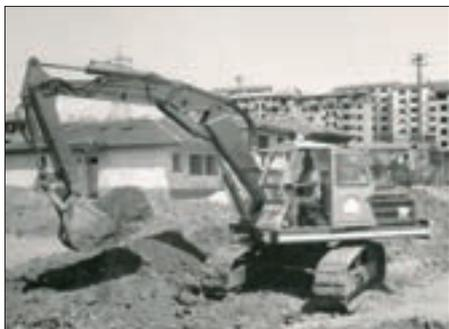
1976: S 517 con telaio cingolato e cabina in plastica nel movimento terra
